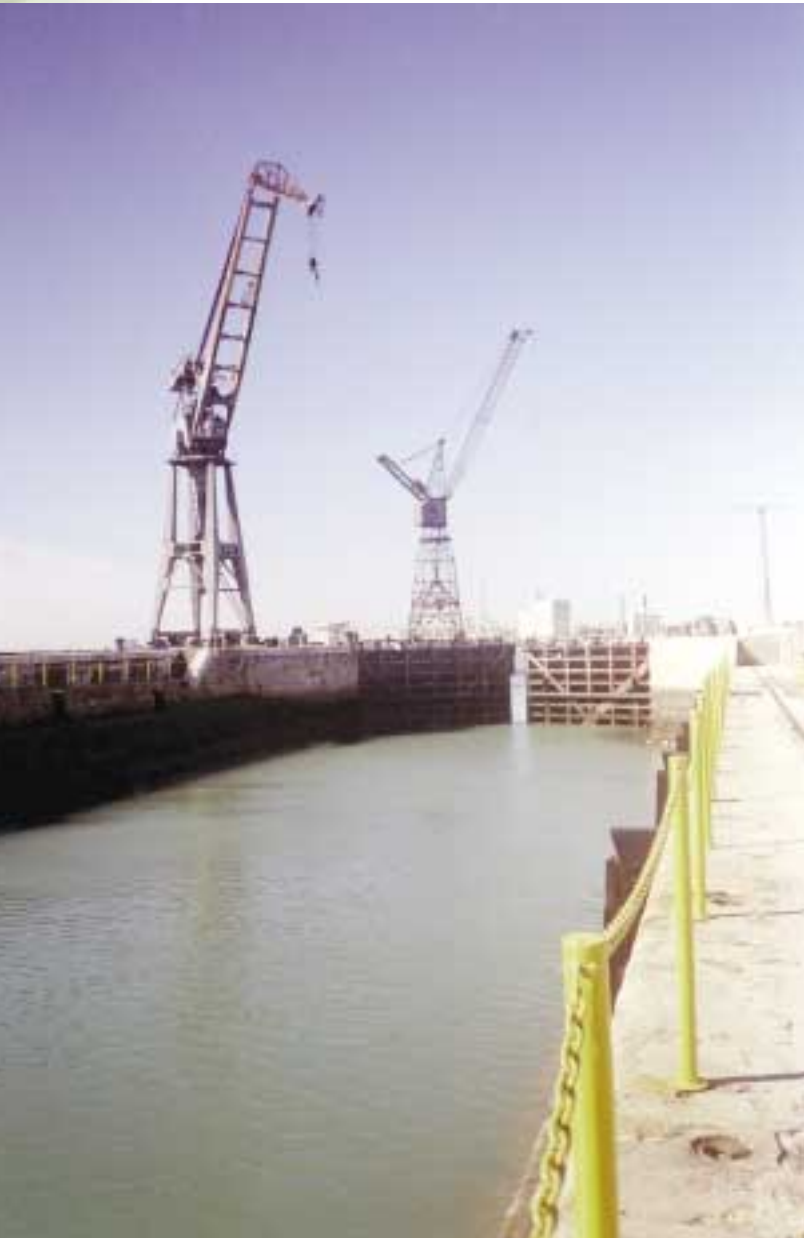
Dique de Matagorda
