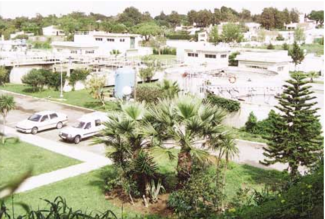
Depuradora de la Barrosa
