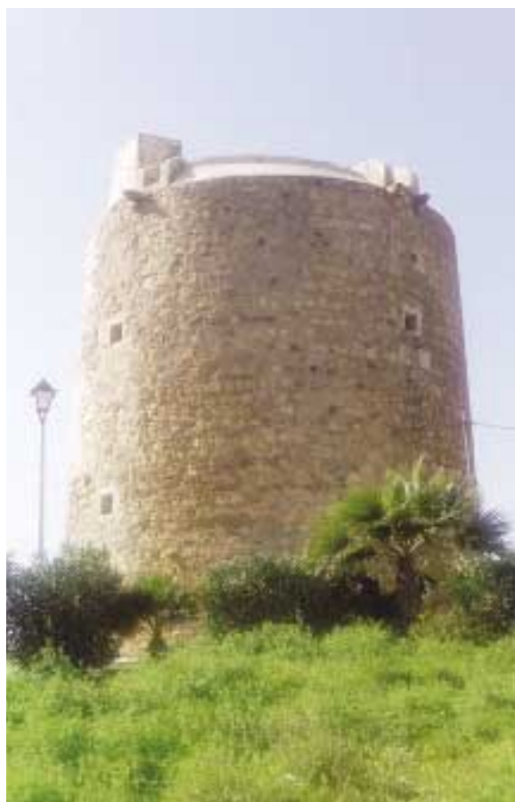
Torre Almenara rehabilitada en Torreguadiaro
