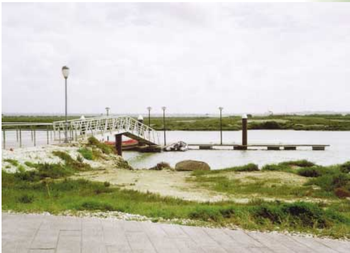
Instalaciones del CREA
